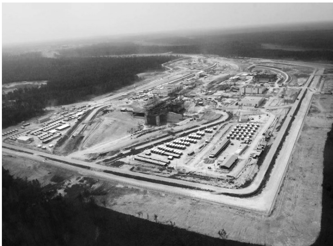
Строительство стартовой площадки для РН “Союз-2” на космодроме Восточный. Отсюда в 2015 г. будет стартовать РН “Союз-2”, а в перспективе – РН “Ангара”. Фото Роскосмоса.
