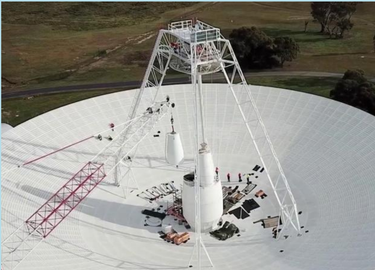
Модернизация и ремонт 70-метровой радиоантенны Deep Space Station 43 в Канберре, Австралия.
